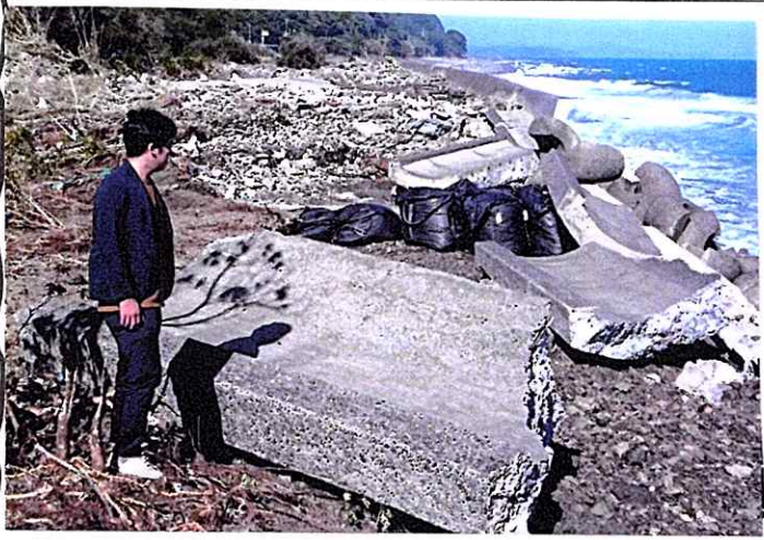
土のうで対応する箇所とです。はやり対応を要している箇所。
